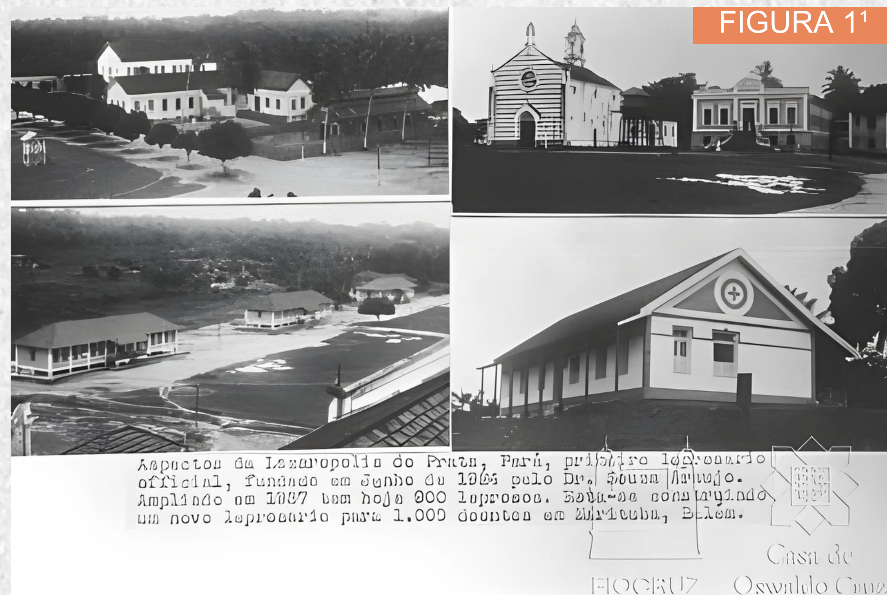
1 SOUZA-ARAÚJO, Heráclides César de. Aspectos de Lazarópolis do Prata, Pará, primeiro leprosário oficial, fundado em junho de 1924 pelo Dr. Souza Araújo. Ampliado em 1937 tem hoje 900 leprosos. Está sendo construído um novo leprosário para 1.000 doentes em Marituba, Belém. Fundação Oswaldo Cruz. Casa de Oswaldo Cruz, s.d.
